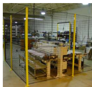
CERCADO DE SEGURIDAD
