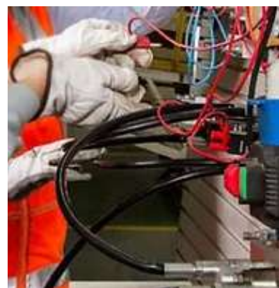
REPARACIÓN DE TRANSMISIONES DE EQUIPOS ELÉCTRICOS
