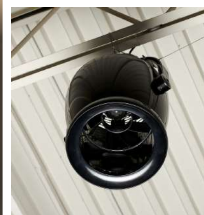
VENTILADORES DE DESESTRATIFICACIÓN
